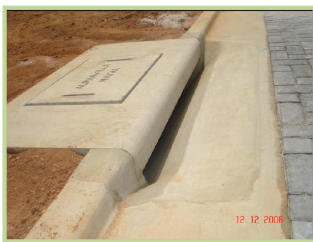
Figura 1.6.6-1: Exemplos de guias, sarjetas e bocas de lobo utilizadas no sistema de drenagem da água pluvial.
